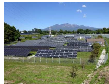
広大な「北杜サイト太陽光発電所」と八ヶ岳
